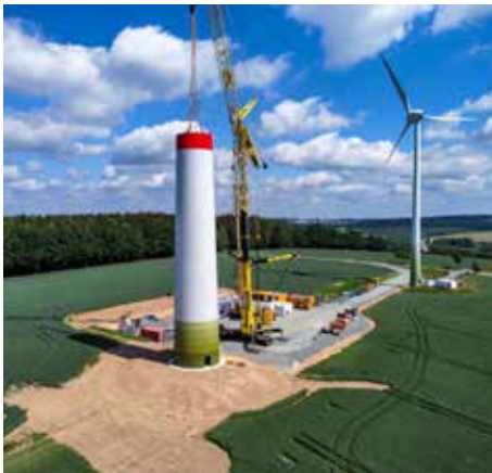
Errichtung einer Windkraftanlage
