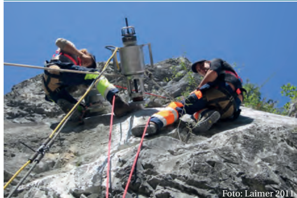
Abb. 53: Installation einer Ankerkraftmessdose
