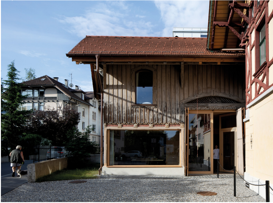
Außenansicht Oeconomiegebäude Josef Weiß nach Umbau
