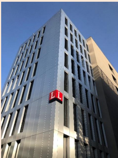
Foto: Demonstrationsgebäude Life Cycle Tower, Projekt CEC5
