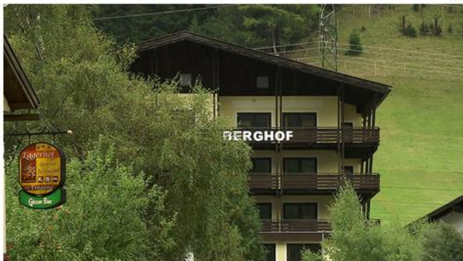
Auch im ehemaligen Hotel Berghof in Mallnitz sollen Appartements entstehen
