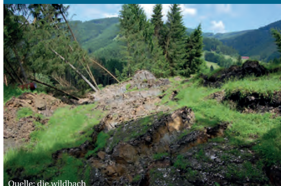
Abb. 4: Rutschung im Waldbereich
