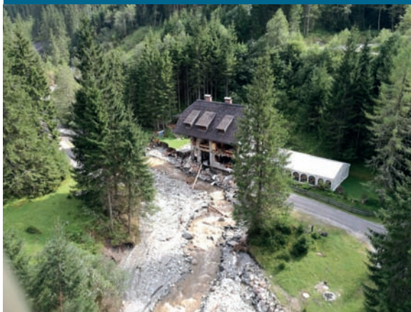
Abb. 5: Stark beschädigtes Gebäude durch Hochwasser
