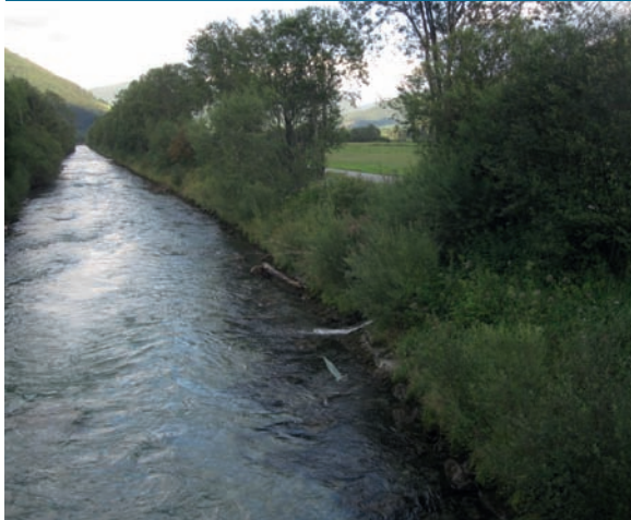
Abb. 17: Flussbett der Mur vor der Sanierung
