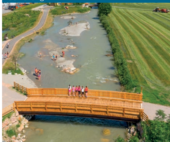
Abb. 16: Flussbett der Enns nach der Sanierung
