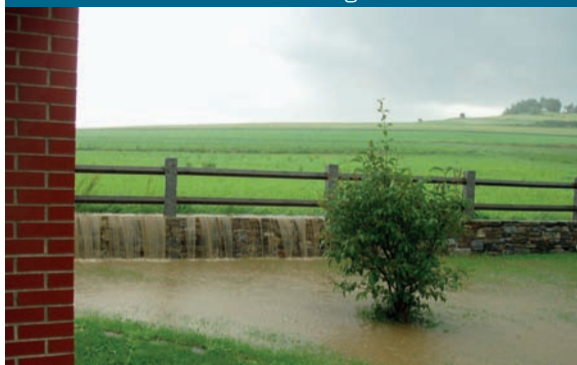
Abb. 23: Abfluss von Hangwasser
