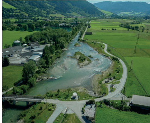
Abb. 18: Flussbett der Mur nach der Sanierung
