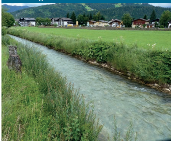
Abb. 15: Flussbett der Enns vor der Sanierung
