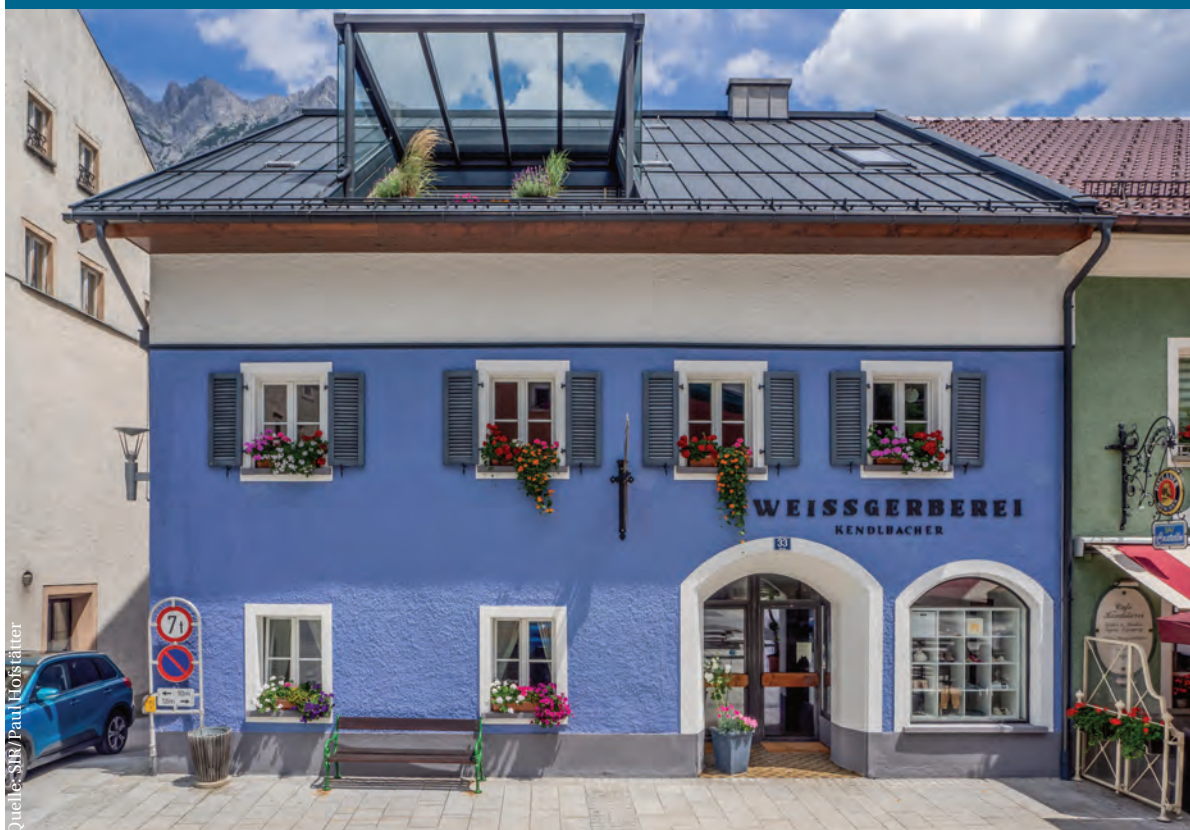
Abb.16: Saniertes historisches Gebäude mit Dachgeschoßausbau
