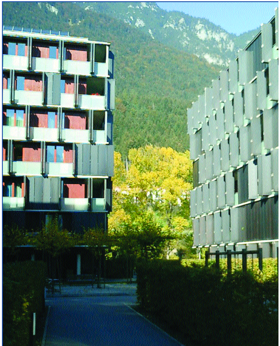
Wohngebietserweiterung Hötting-West 1. Bauphase Neue Heimat Tirol (Foto: Stadtplanung)
