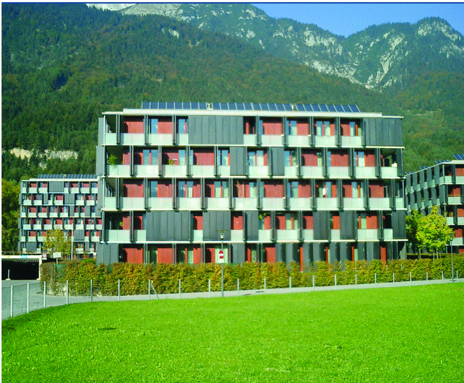
Wohngebietserweiterung Hötting-West 1. Bauphase Neue Heimat Tirol (Foto: Stadtplanung)
