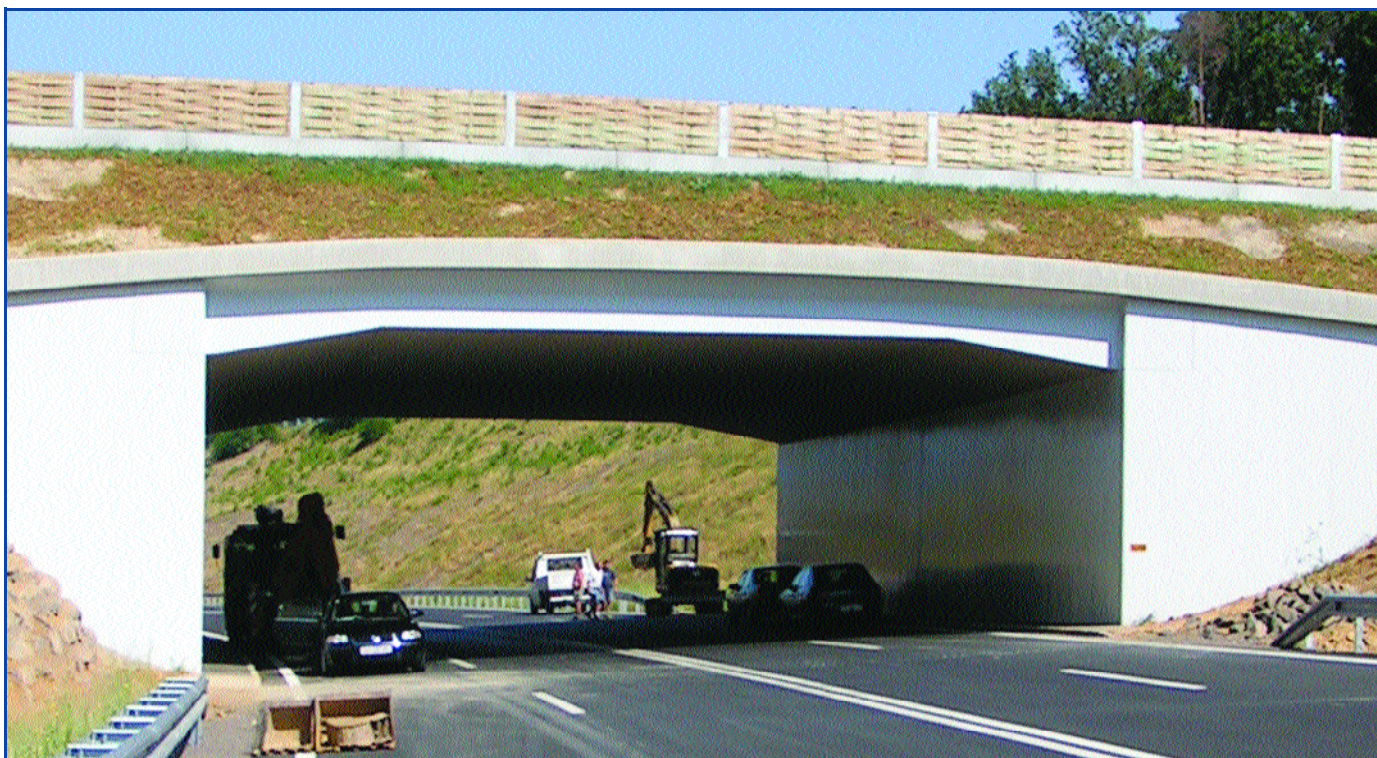
Grünbrücke zur Wildquerung (im Bauzustand, ohne Bewuchs)
